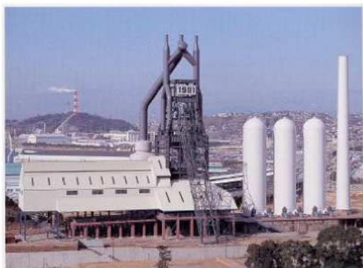
東田第一高炉跡
