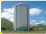
▲平尾台配水池
