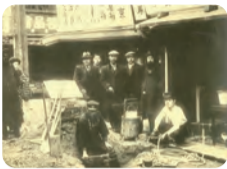
▲水道創設時の給水管布設(門司市)
