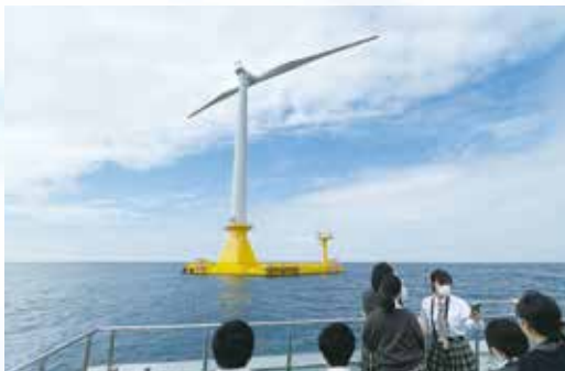
洋上風力発電施設
