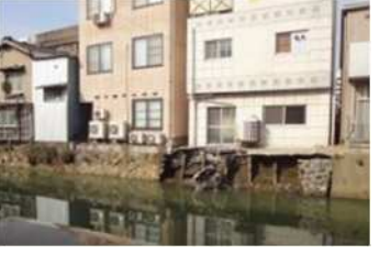
左岸護岸の崩壊(H26.3)
