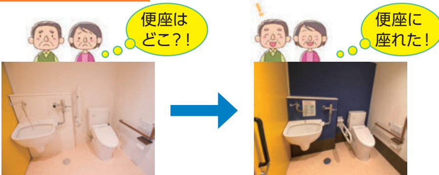
全てが同じような色合いだと見つけにくく、便座の場所がわからない 明確なコントラストをつけることで、探さなくても目に入る
