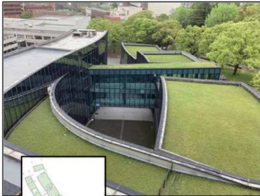
＜屋上緑化の状況＞
