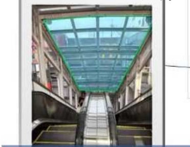
エスカレーター天井
