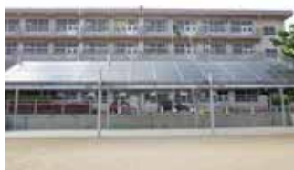
太陽光発電設備（出力10kWの設置例）
