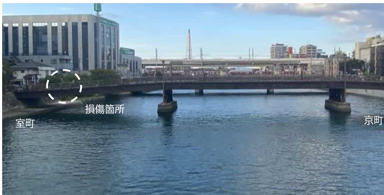
【勝山橋（南側）から撮影】
