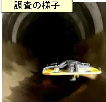
ドローンによる目視調査
