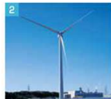
2 陸上風力 エネ・シードウィンド(株) 発電能力：4,000kW 基数：2
