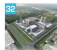
32 石炭バイオマス混焼発電 (株)響灘火力発電所 発電能力：112,000kW 基数：1
