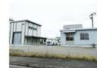
グリーンLPG直接合成 技術開発実証研究施設 ■研究主体 日本グリーンLPGガス推進協議会
