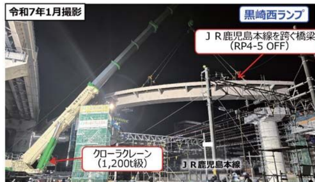
▲架設時の状況 (JR 鹿児島本線を跨ぐ橋梁)
