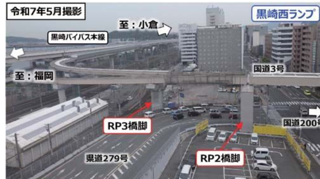
▲橋梁架設後の状況 (国道 3 号から小倉方面を望む)
