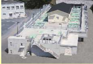
高度浄水施設（穴生浄水場）
