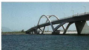
海の中道大橋(福岡市東区)
