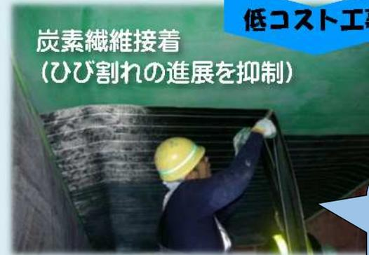
損傷の進行を抑制する効果が高いため、永久的ではないが、延命化を図ることが可能
