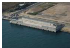
響灘リサイクルポート岸壁
