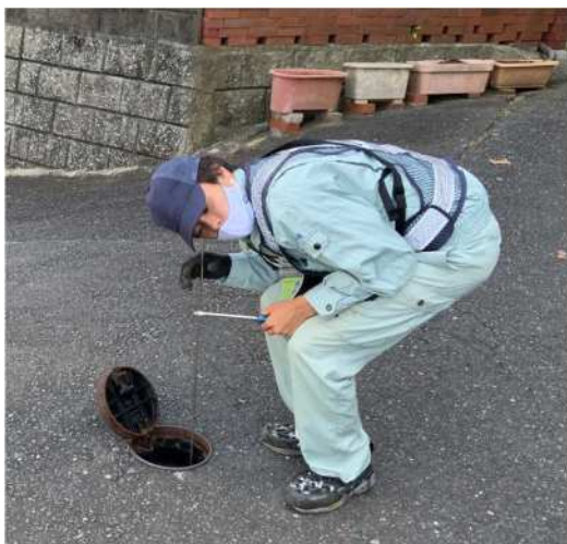
バルブ等の漏水音を音聴棒で調査
