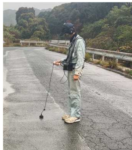
道路上での漏水音聴調査
