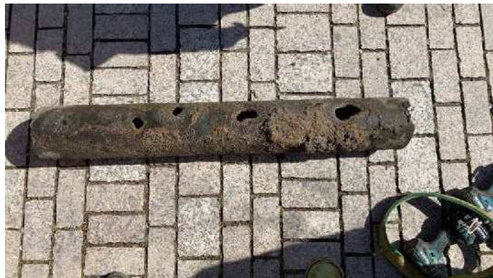
S53年に整備した水道管（配水管）
