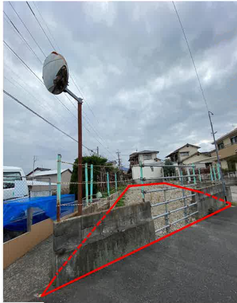
現地写真(北東から撮影) 小倉南区津田四丁目584番11
