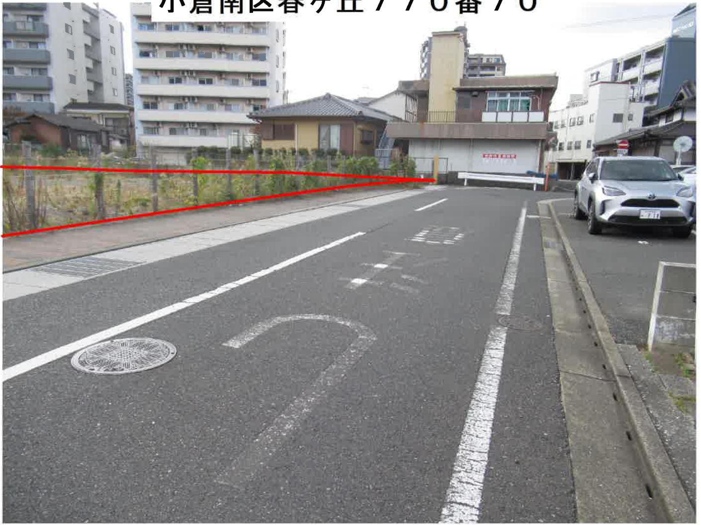
現地写真③（北東から撮影）
