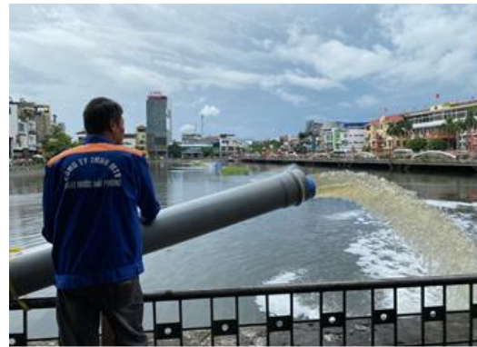
ポンプによる排水訓練
