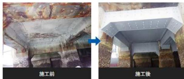
減肉した鉄筋の取換作業
