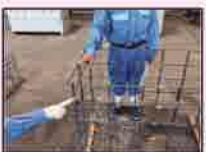
【立会状況（配筋確認）】
