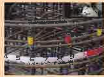
【立会状況（現場側）】
