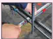
【立会状況（配筋確認：近接）】
