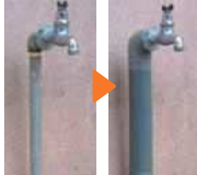
保温チューブの取付
