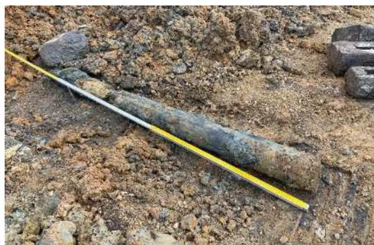
【木製杭引き抜き状況(約2.25m)】
