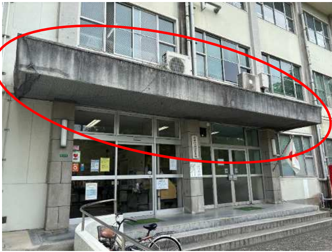
庇のモルタル(コンクリート) 落下防止ネット設置
