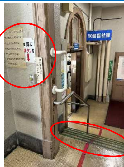
廊下の途中に階段 (車椅子、ベビーカー等の方の移動が困難)
