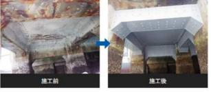
減肉した鉄筋の取換作業 重量、海上足場での煩雑な作業 鉄筋工の減少・・・ 鉄筋の腐食リスクが残る・・・
