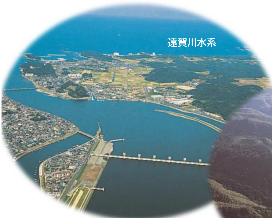
遠賀川河口堰
