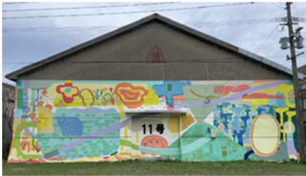
【梶山倉庫第11号倉庫(門司区東港町4)の壁面】
