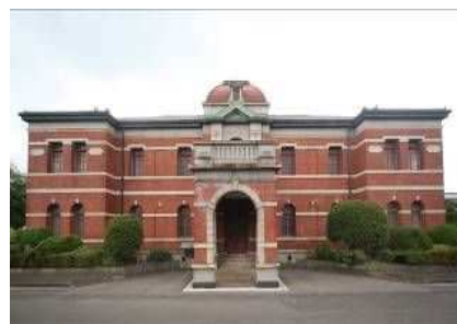
写真提供：日本製鉄㈱九州製鉄所 （※一般には非公開の施設です）
