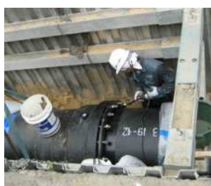
水道管路の耐震化(耐震管布設)
