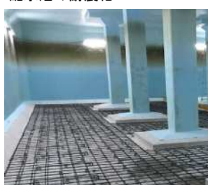
配水池の耐震化
