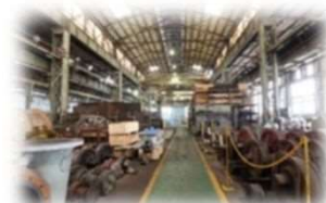
【修繕工場】 令和13年度以降 着手予定
