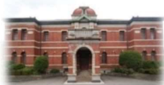
【旧本事務所】 平成30年度着手 令和2年度完了
