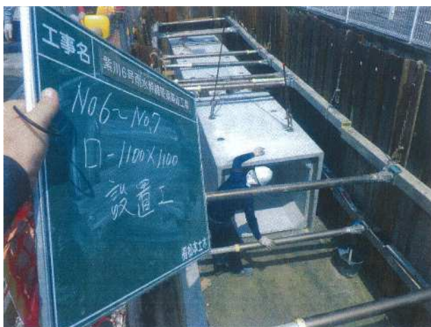
雨水管の整備
