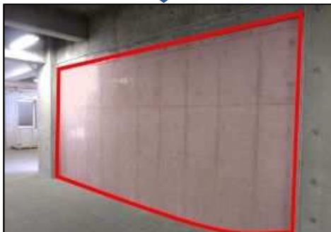
補強後 (中空部に耐震壁を設置)
