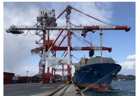
【太刀浦コンテナクレーン】
