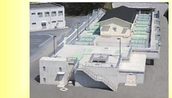
高度浄水施設（穴生浄水場）
