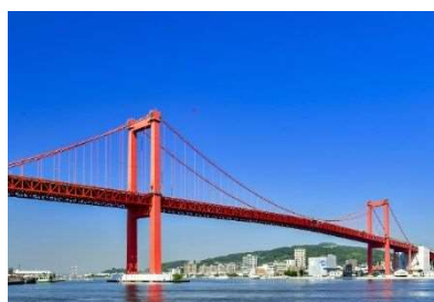
～若戸大橋・若戸トンネルの強靱化～
