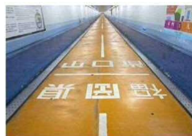
関門トンネル人道
