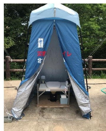
【災害用マンホールトイレ】
