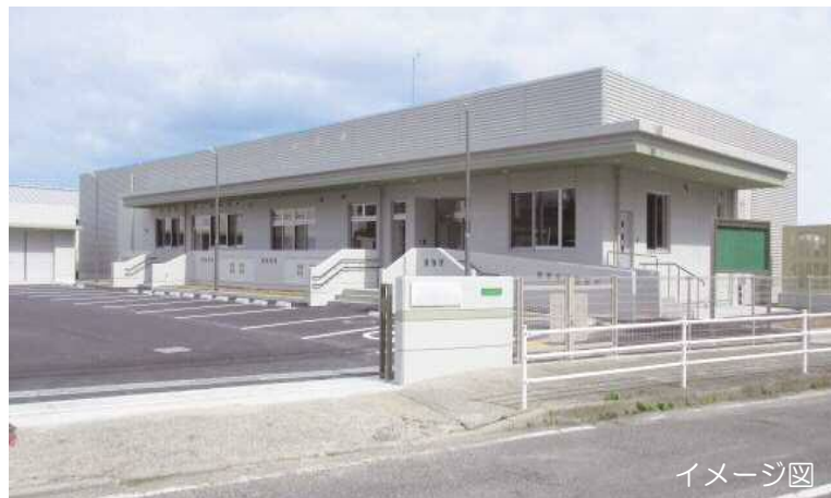
【避難場所の整備・改修：市民センターの改修】
