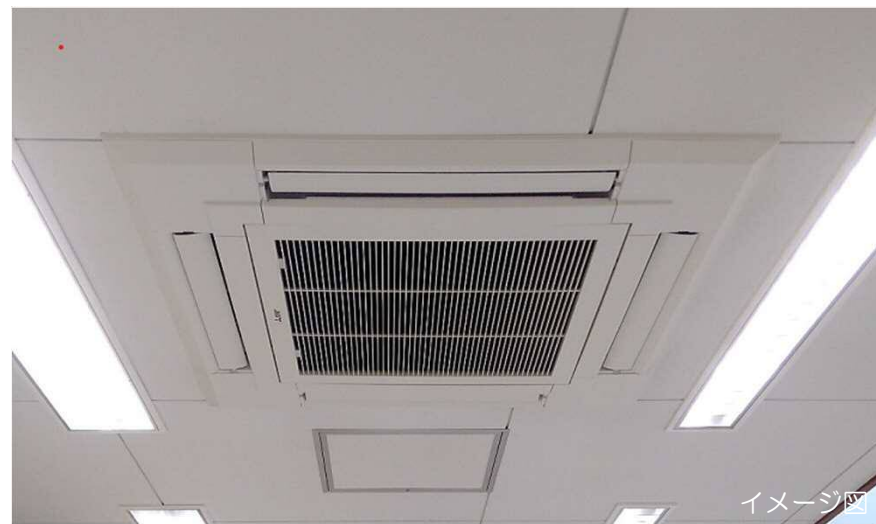
【空調設備の改修等】
