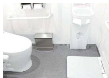
ベビーチェア、フィッティングボードが設置されたトイレ
