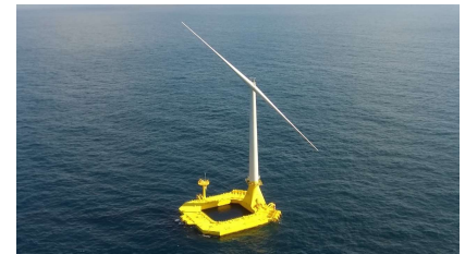
「ひびき」(提供: NEDO)
