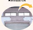
▲解体直前写真
