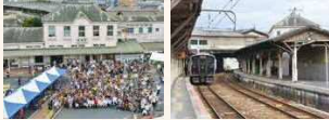
▲ありがとう折尾駅舎 (解体直前にイベントを開催) ▲解体直前の駅構内 (筑豊本線ホームの様子)
