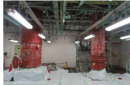
溶剤蒸留回収室 塔保温撤去
