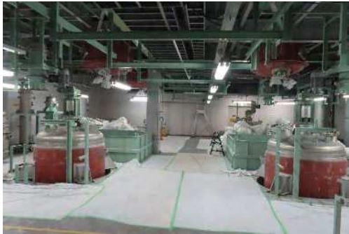
液処理室タンク保温撤去
