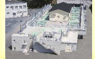
高度浄水施設（穴生浄水場）
