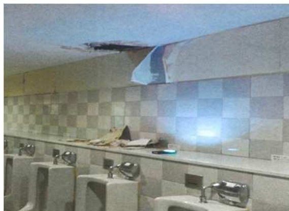
◇3階トイレ天井崩落
