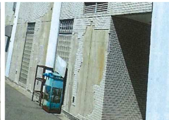
◇外壁タイル剥落
