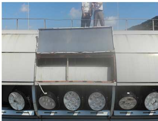
◇屋上外壁パネル破損
