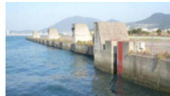
図 2-18 耐震強化岸壁の整備(砂津地区)
