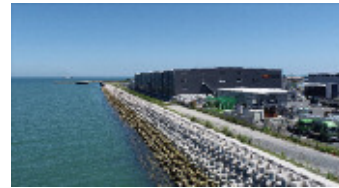
図 2-17 護岸整備(新門司地区)
