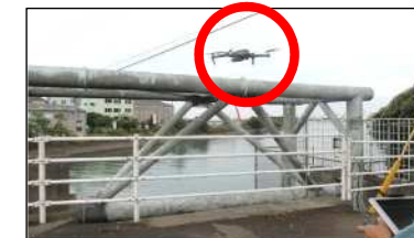
ドローンによる水管橋の調査
