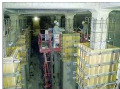
配水池の耐震補強工事
