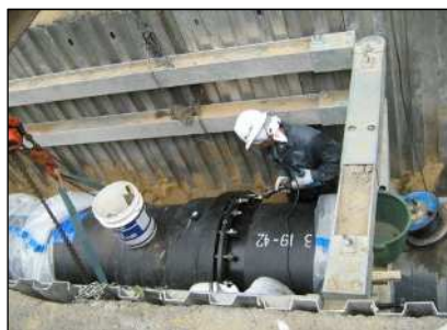
耐震管布設工事
