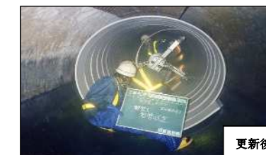
管更生工事による改築更新
