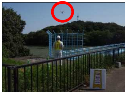
ドローンによる水管橋調査
