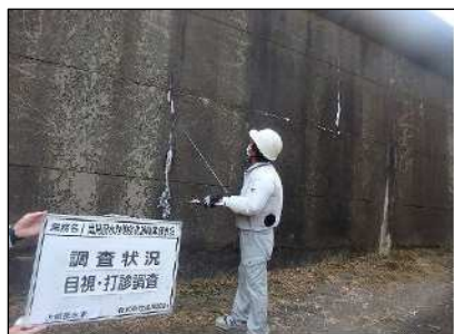
コンクリート構造物（浄水場、配水池）の点検・調査
