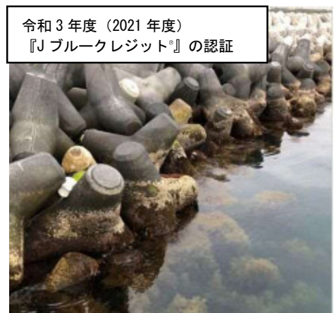
J-POWER 若松総合事業所の周辺護岸における ブロック設置による藻場造成
