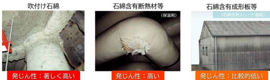
石綿の使用方法（例）
