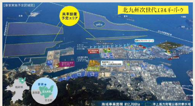
北九州次世代エネルギーパーク
